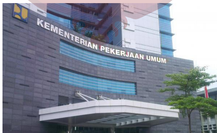
Gambar 2.8 Gedung Kementerian PUPR (Sumber: Dokumen Kementerian PUPR )
