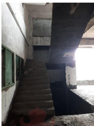
Foto Dokumentasi Bangunan Lantai 3 (Sumber : Dokumen Pribadi, 2025)
