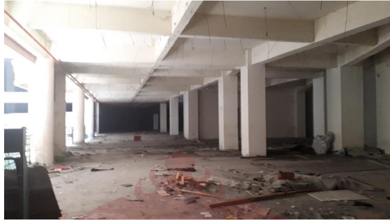
Foto Dokumentasi Bangunan Lantai 2 (Sumber : Dokumen Pribadi, 2025)
