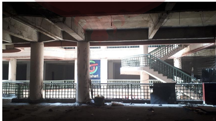
Foto Dokumentasi Bangunan Lantai 2 (Sumber : Dokumen Pribadi, 2025)
