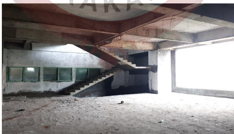
Foto Dokumentasi Bangunan Lantai 3 (Sumber : Dokumen Pribadi, 2025)
