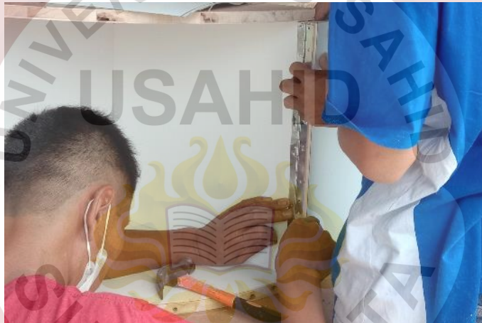
Lampiran 7. Pemasangan engsel pintu (Sumber : Anisa Nurul Octavia, 2023)
