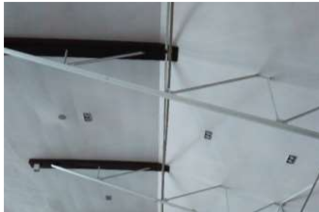
Gambar 16. Detail Plafon bagian Hall Domestik (Sumber: Dokuntasi Hasil Survey, Mei 2018)
