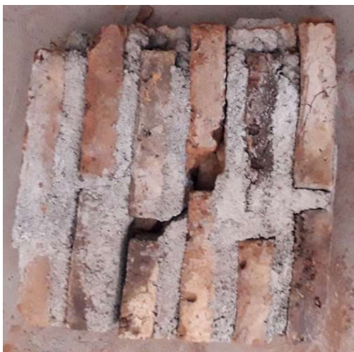
Gambar 8. Retakan batu bata uji diagonal
